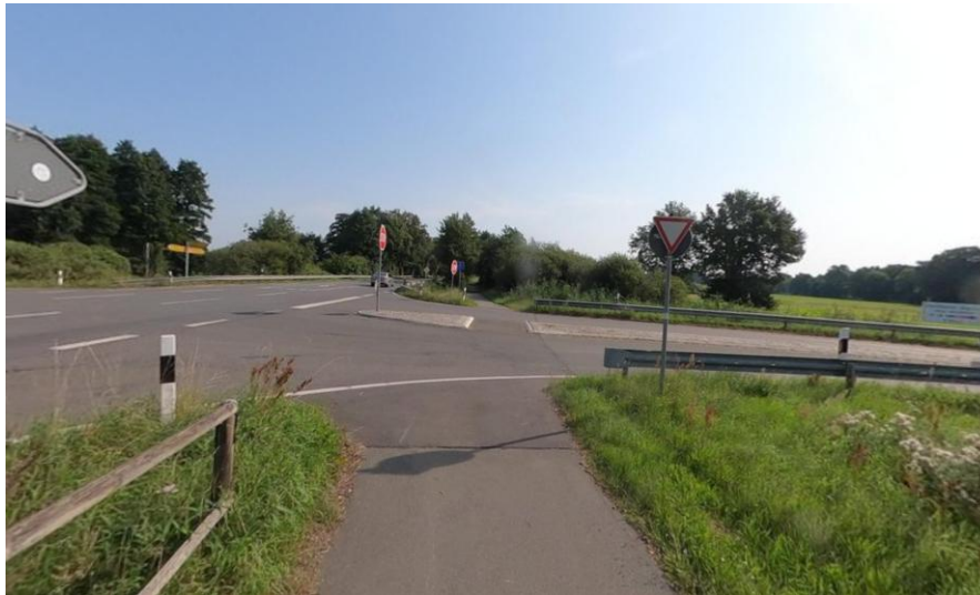
Abbildung 47: Beispiel untergeordneter Radweg obwohl entsprechend der Grenzwerte eine bevorrechtigte Führung vorzusehen wäre (B 191 bei Quickborn)
