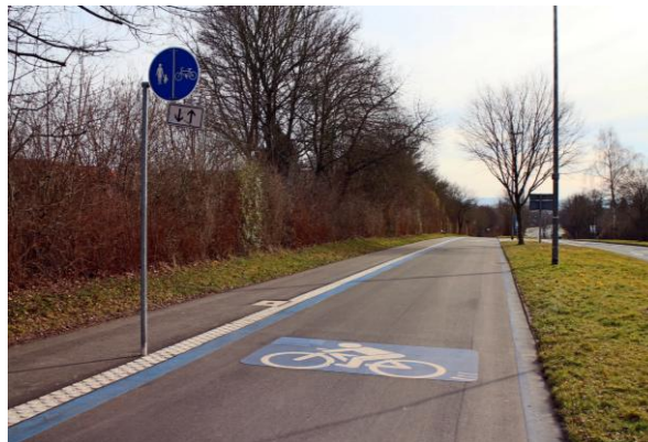
Abbildung 54: Beispiel für einen mittels Trennstreifen taktil abgesetzte Radweg mit Orientierungshilfe für Passanten mit Sehbehinderung in Göttingen
