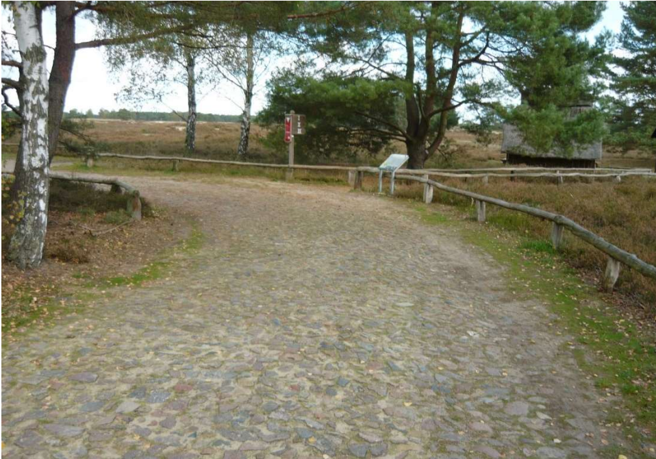
Abb.4: Beginn des Wanderwegs in die Nemitzer Heide (an der Infotafel), Feldsteinpflaster als Wegebefestigung
