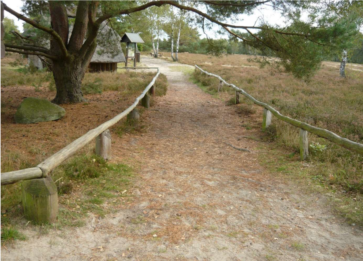
Abb. 5: Der Weg hat am Anfang der Heide eine Breite von ca. 1,70 m (Abstand zwischen den Leitstrukturen ca. 2,20 m).
