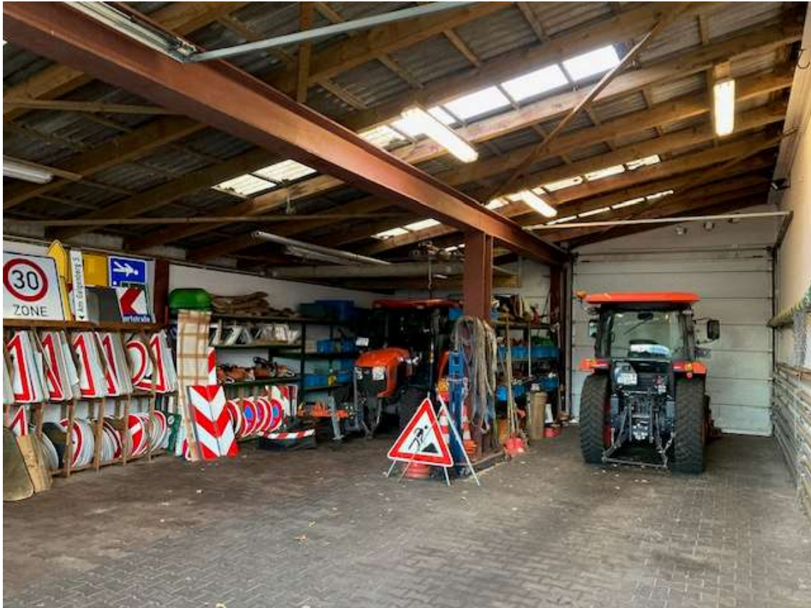
Angebaute Fahrzeughalle innen
