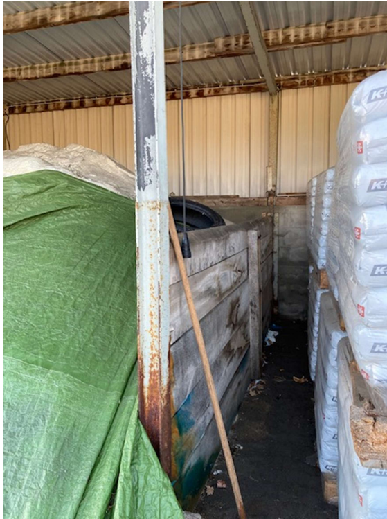
Korrosion an den Stahlstützen
