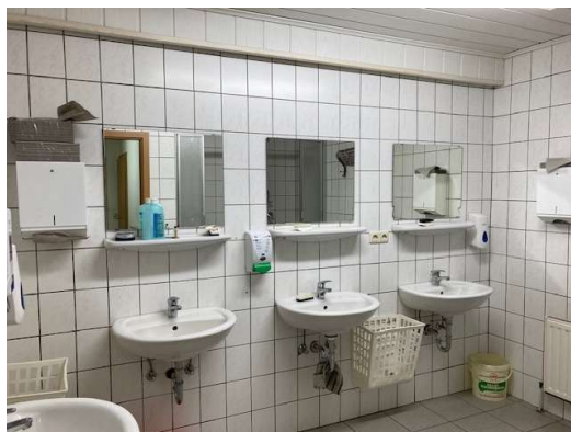
Sanitärraum, Flur und Büro
