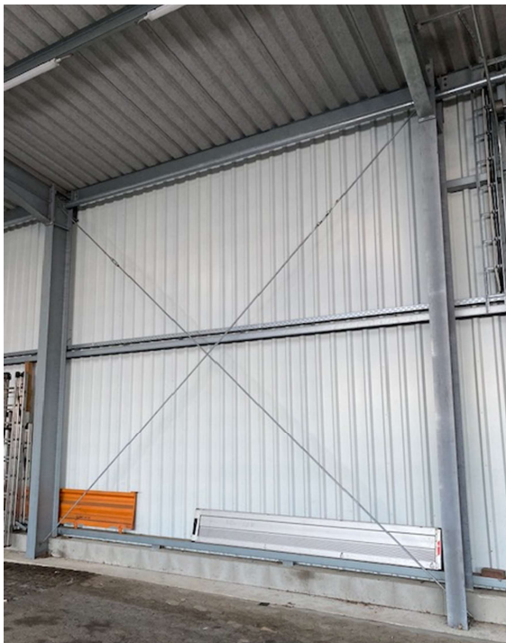
Konstruktion Halle innen
