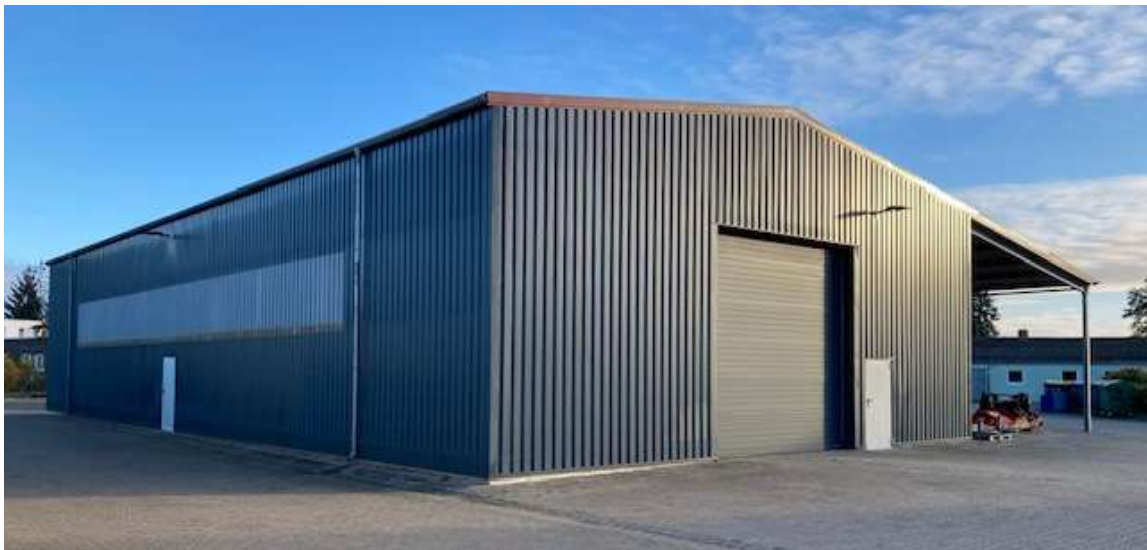
Ansicht von Süd-West
