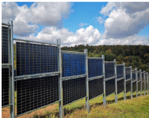
Gestellsystem der Firma Next2Sun GmbH
