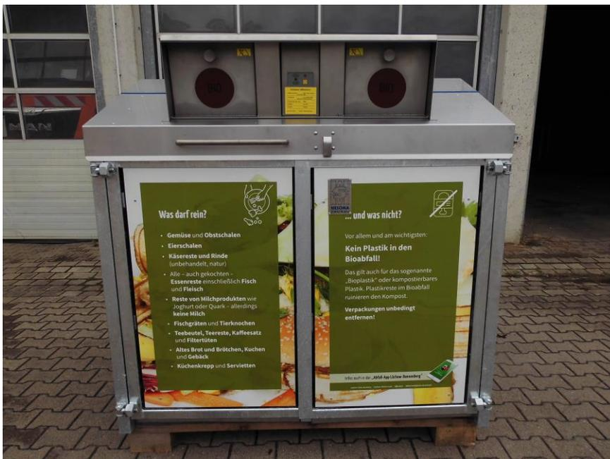
Auf den Schleusen sind Hinweise angebracht, welche Abfälle eingeworfen werden dürfen und welche nicht. Die Schleusen sind mittels eines Chips zu öffnen. Die Einwurfklappen werden freigegeben und die Abfälle können über eine Rutsche in die sich darunter befindlichen 240 l MGB gegeben werden.
