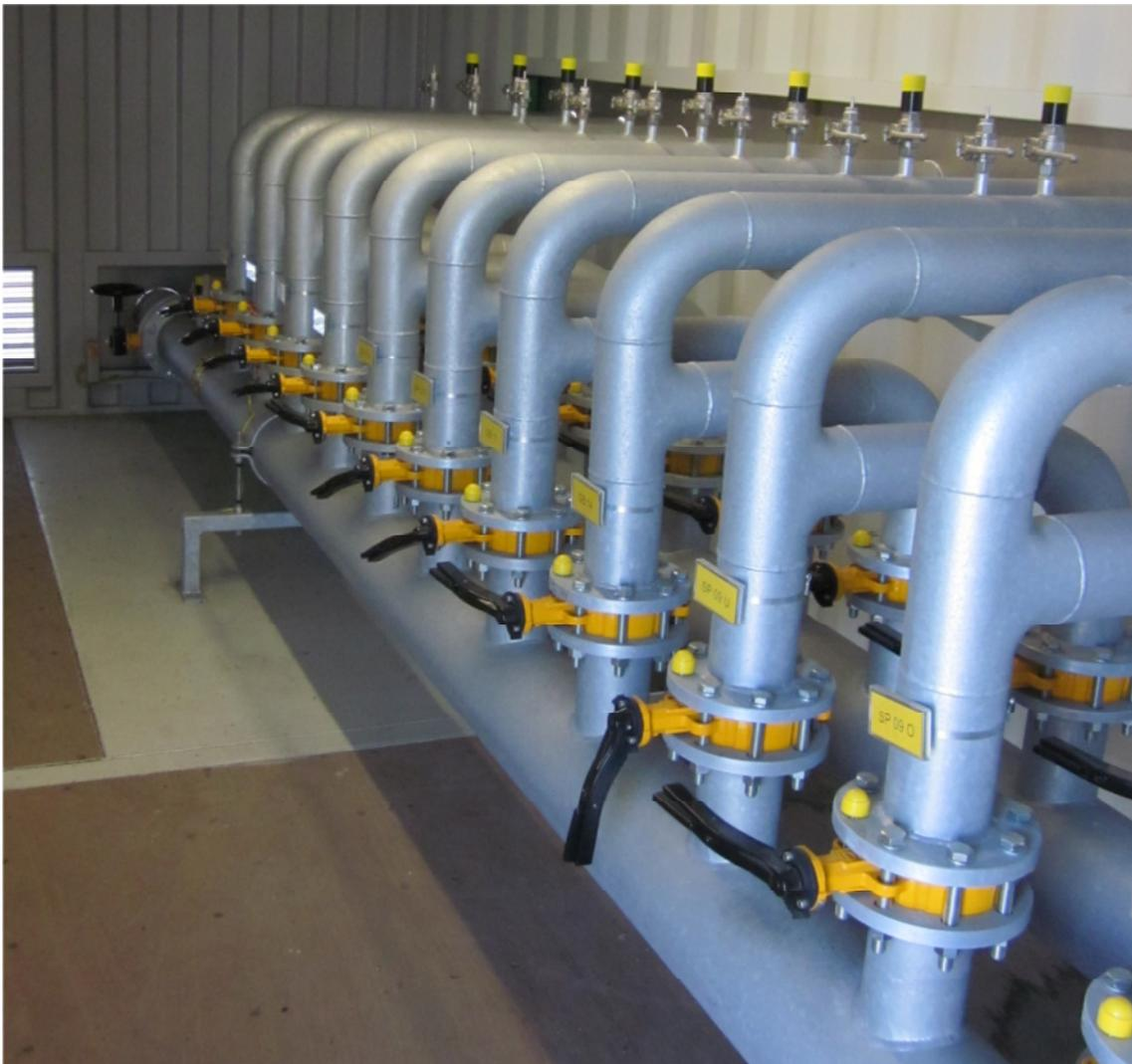
**Abb. 4.2:** Ausführungsbeispiel eines Belüftungs- und Gasfassungssystems in einer Gasverteilerstation auf einem Deponiestandort in Niedersachsen
